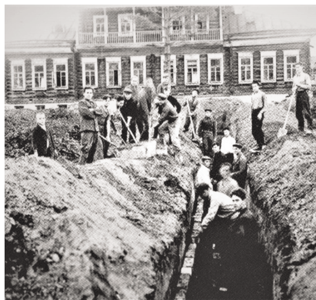
Строительные работы на территории бывшего женского монастыря, сентябрь 1948 г. Публ. по: Томский политехнический университет: история в иллюстрациях / сост. С.И. Никифоров. Томск, 2016. С. 201.
